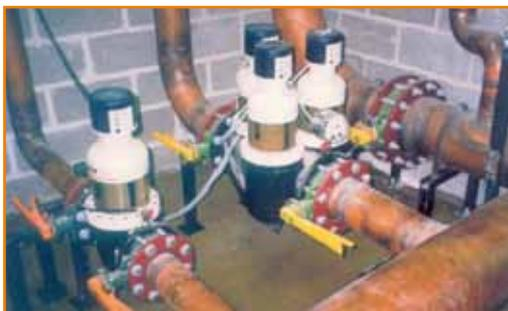
Trinkwasserfiltration durch JPF-ATP DN 100 und DN 150
