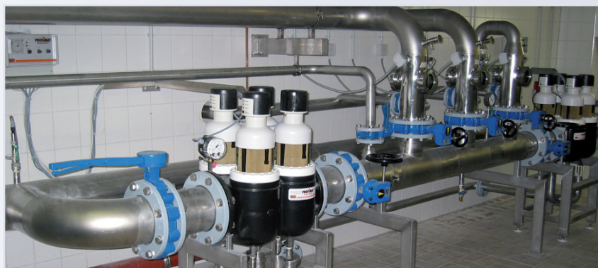
Einbaubeispiel PROFIMAT-ATP DN 200
