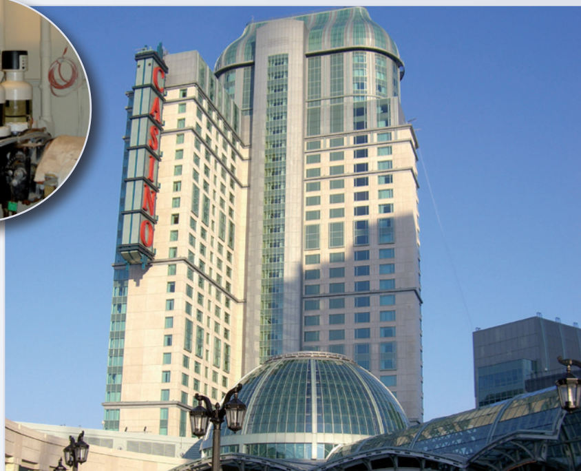
Einbaubeispiel PROFIMAT-ATP DN 200 im Hotel und Casinokomplex „Niagara Fallsview“ in Kanada
