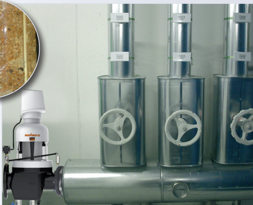
Durch das Schauglas kann der Siebeinsatz von außen auf Verunreinigungen kontrolliert werden
